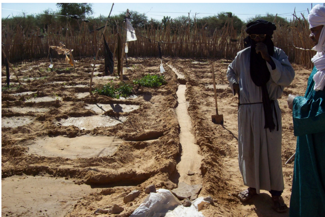
7. Un site familial de cultures maraîchères en cours d'installation dans le GM de Amazzégri
